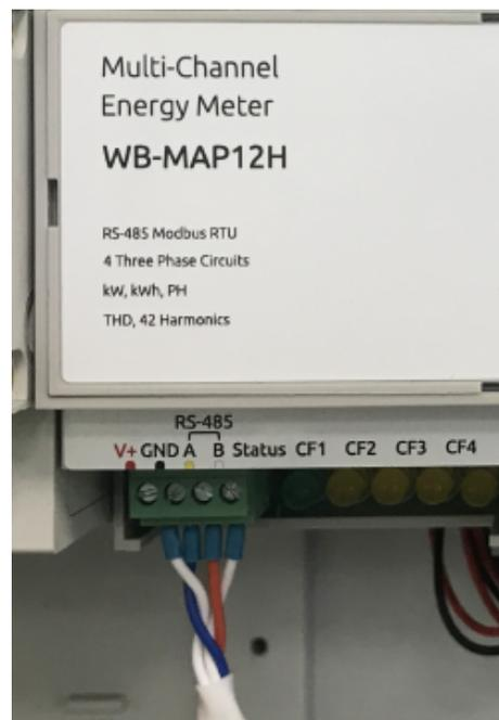
Подключение низковольтного питания и шины RS-485 к счетчику
